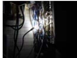
配電盤・分電盤内の 配線確認に
